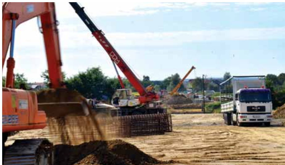
Radovi na nadvožnjaku kod kolodvora Vrbovca
