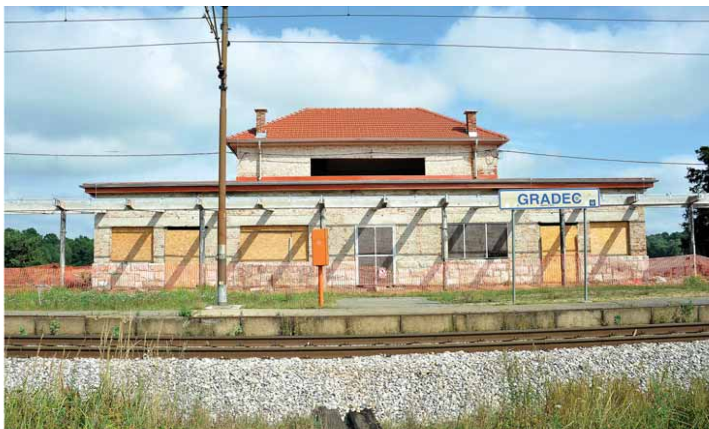
Radovi na kolodvoru Gradecu
