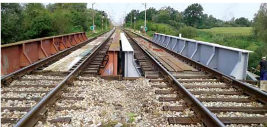
Privremena mosna konstrukcija
