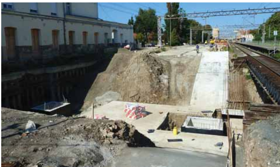
Radovi na iskopu za pothodnik
