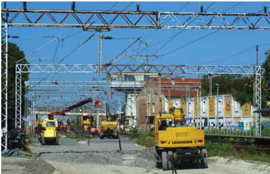
Radovi na gornjem i donjem ustroju
