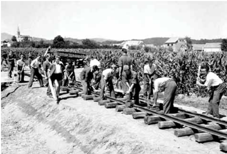
Radovi na Pionirskoj željeznici
