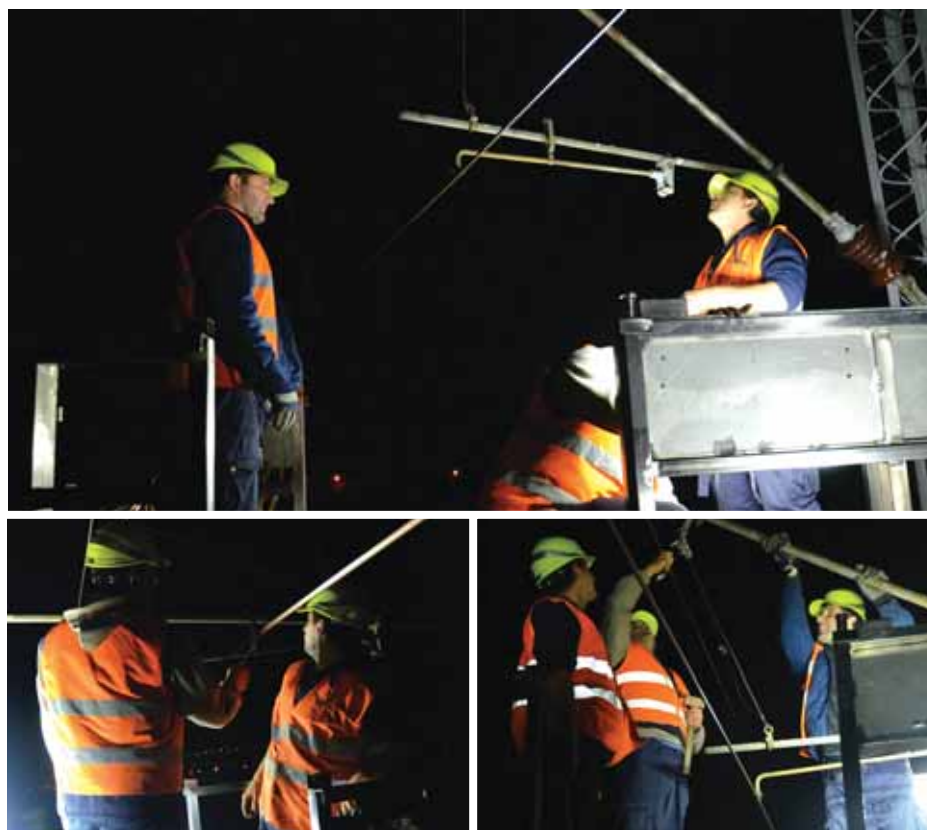
Obnova dijelova kontaktne mreže
