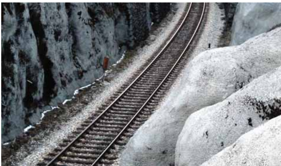
Radovi na dionici Plavno – Pađene
