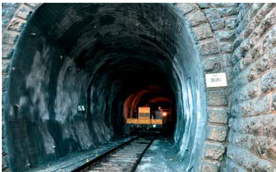
Sanacija tunela Zaluka
