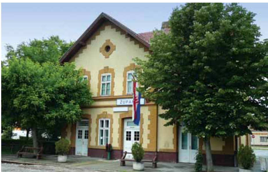
Željeznički kolodvor Županja
