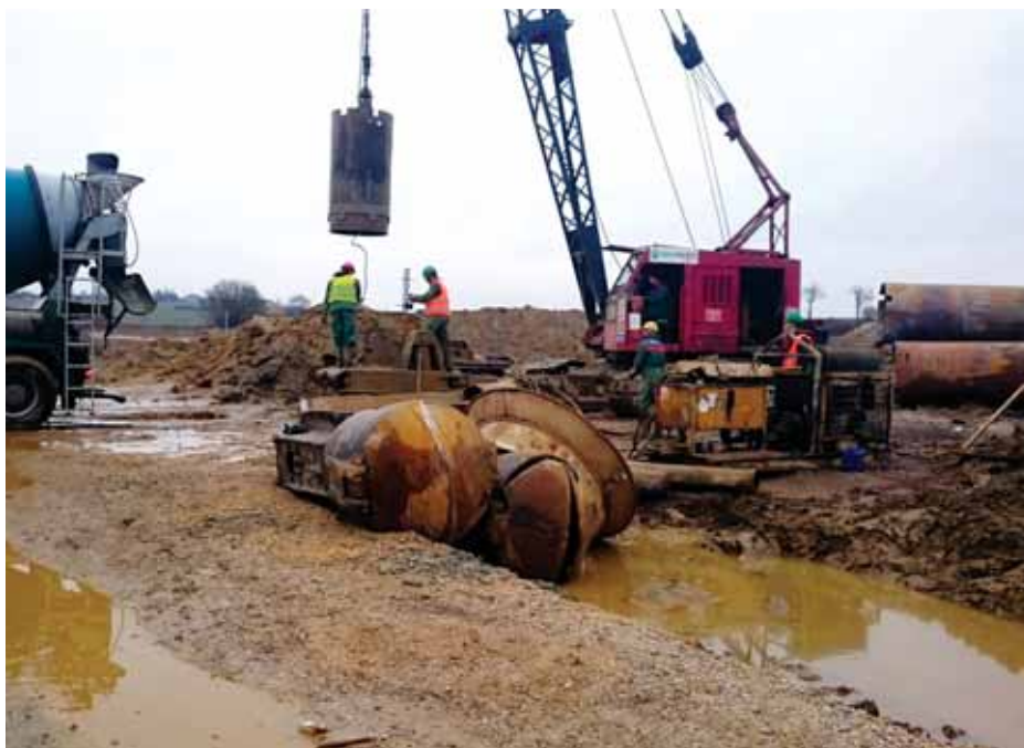
Radovi na izgradnji nove željezničke pruge Gradec – Sveti Ivan Žabno
