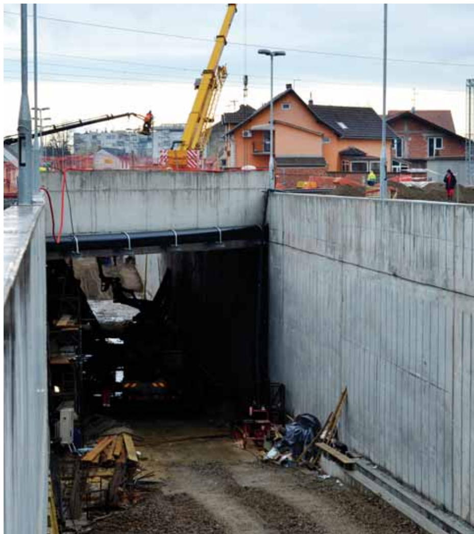
Radovi na izgradnji podvožnjaka u Osječkoj ulici u Slavonskome Brodu
