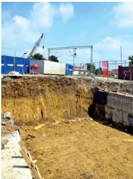
Radovi na podvožnjaku
