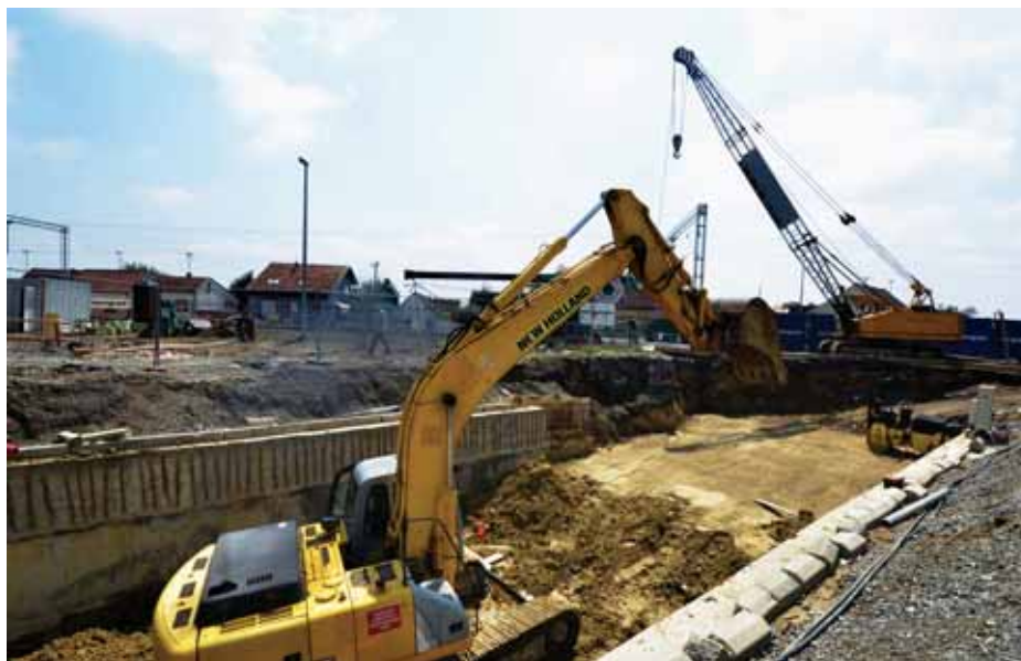
Radovi na podvožnjaku
